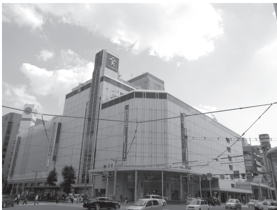
業態転換を行う天満屋八丁堀ビル
