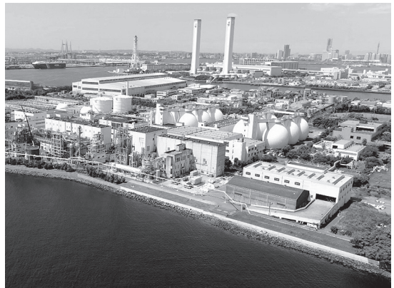
北部汚泥資源化センター
